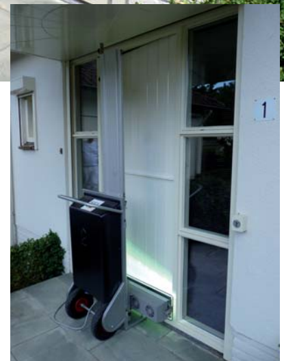
Na de infrarooddroging komt het UV-uitharding.
