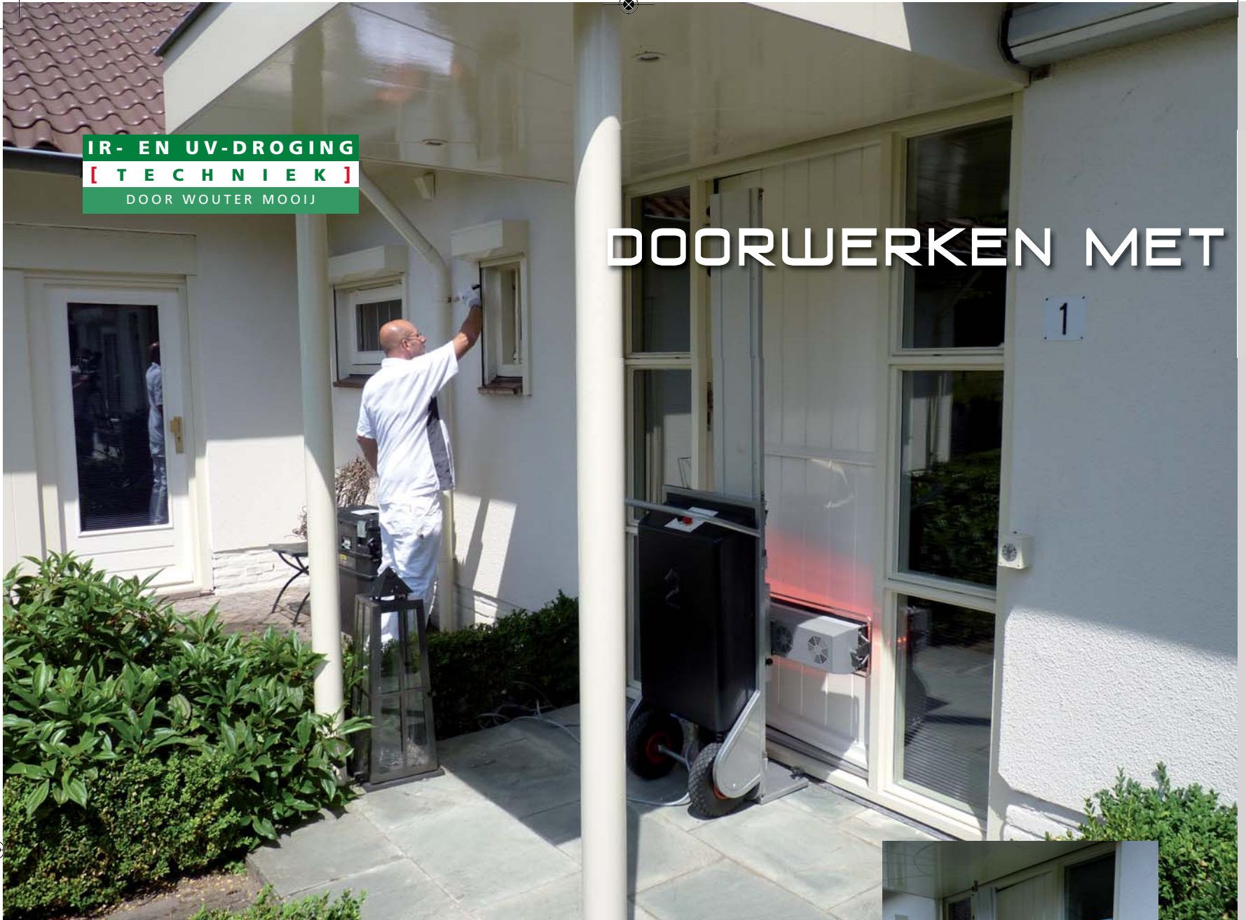
De nieuwe DecoRad-robot in actie (infrarood droging), terwijl de schilder een raam onderhanden neemt.
